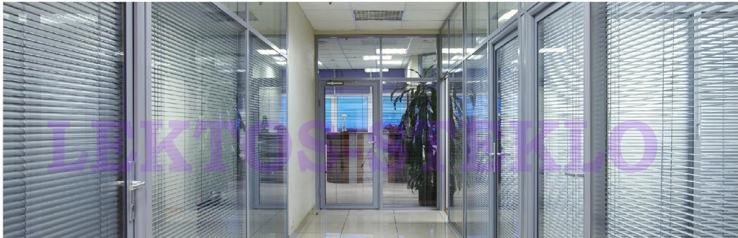
Конструктив : стойки ставятся в распор между полом и потолком.
